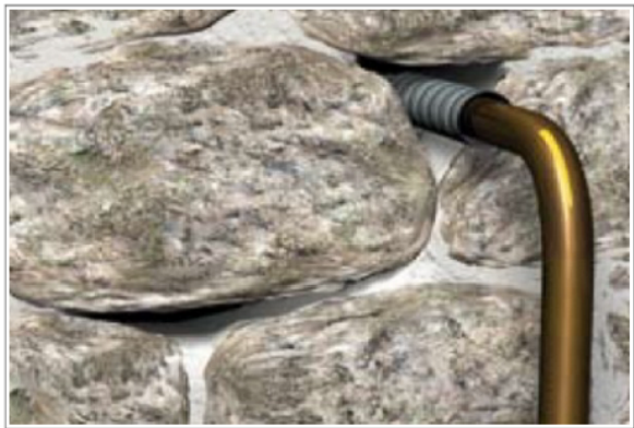
Situation initiale avant colmatage
